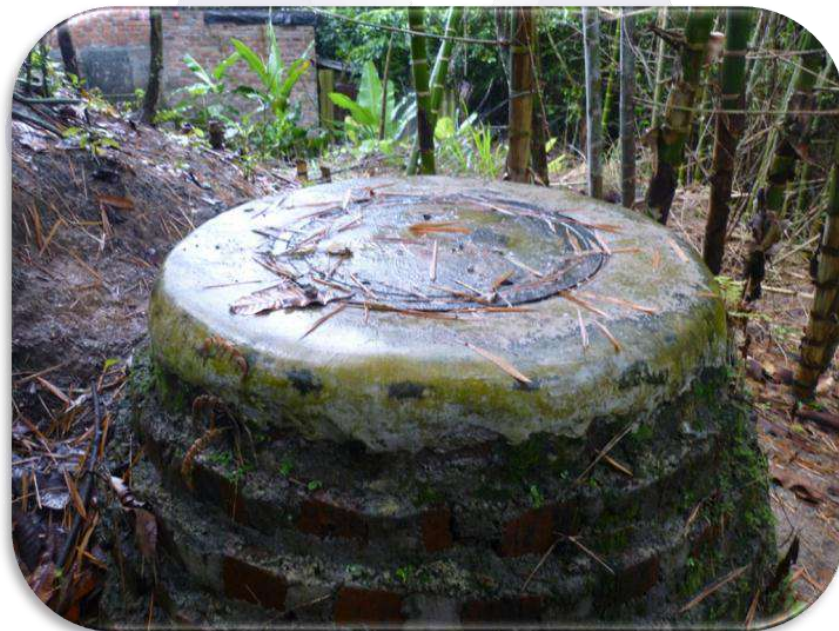
Fotografía No. 5 pozos de inspección construido
