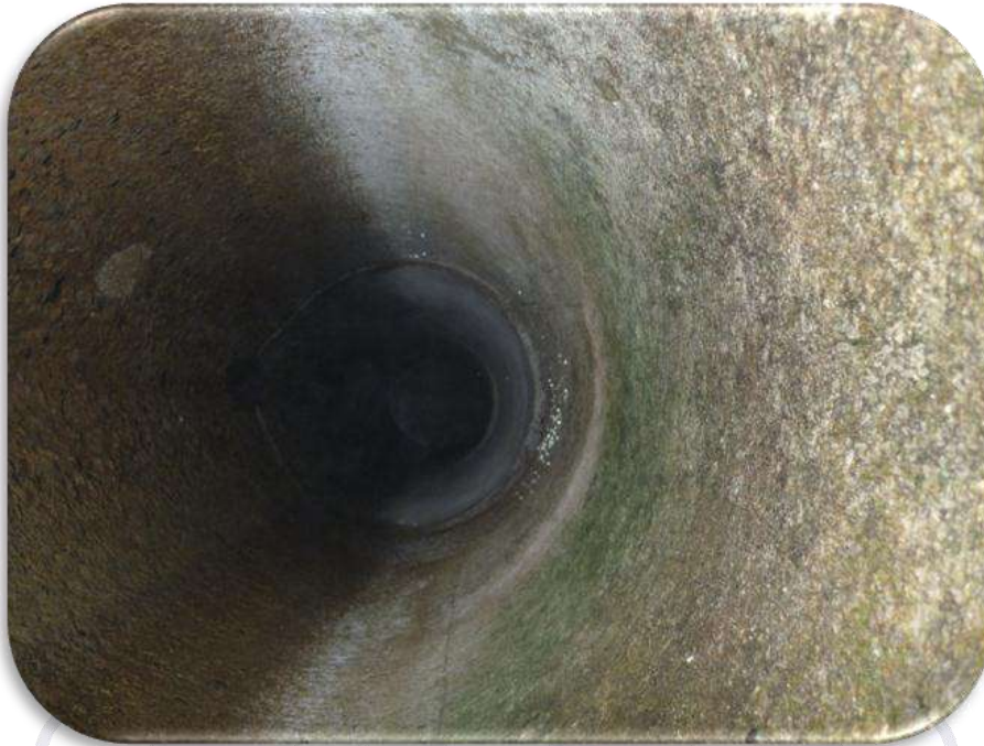
Fotografía No. 2 Pozo de inspección
