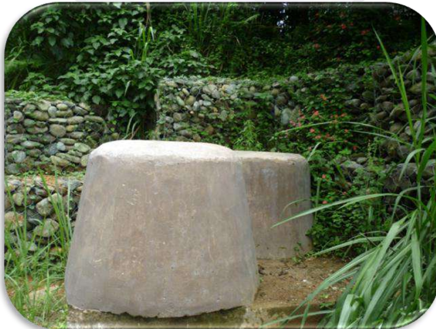
Fotografía No. 3 pozos de inspección contruidos
