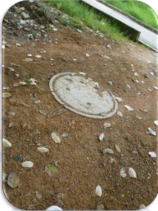
Fotografía No. 10 Construcción alcantarillado
