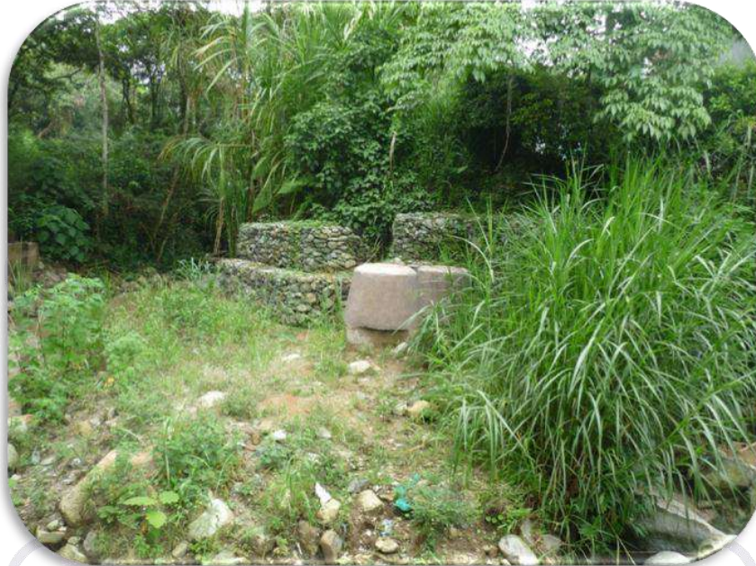
Fotografía No 4 Vista pozos de inspección construidos
