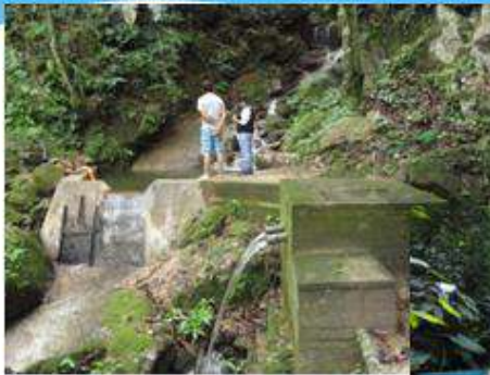
Toma del sobrante de la bocatoma del acueducto de la Paz el caudal concesionado por cortolima
